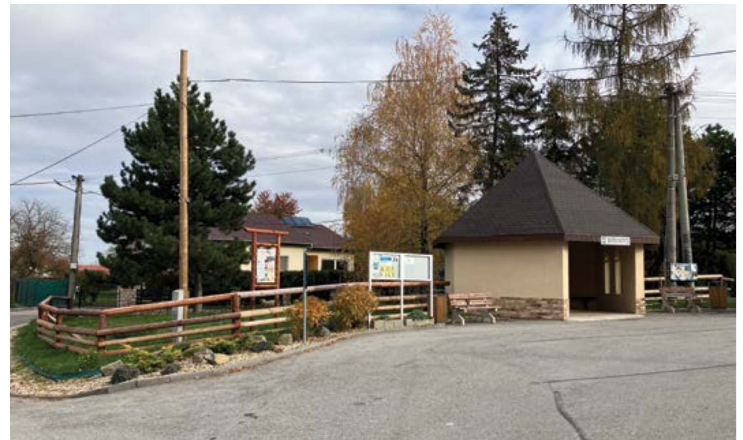
Opravená zastávka a nový drevený plot.
