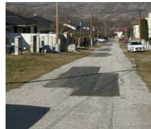
Opravené výtlky na ceste.
