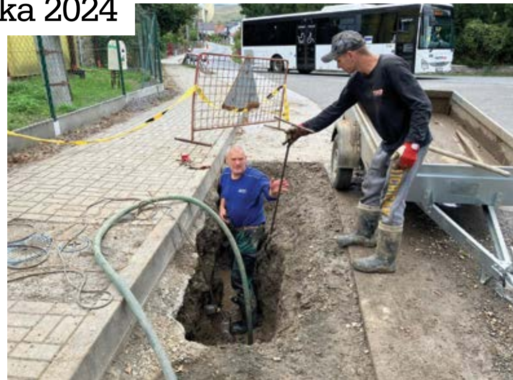
Oprava poruchy na vodovode pri škôlke
