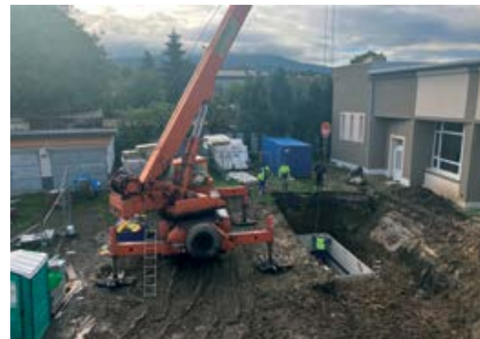
Osadenie nádrže na zachytávanie dažďovej vody.
