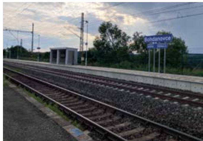
Rekonštruovaná železničná zastávka Bohdanovce.
